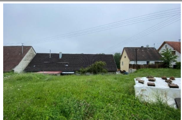
Blick nach Osten über den Gartenbereich auf das abzureißende Gebäude.
