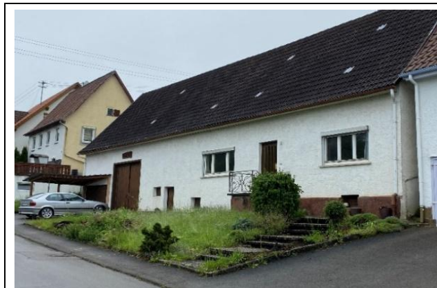
Blick von der Egertstraße auf das abzureißende Gebäude.
